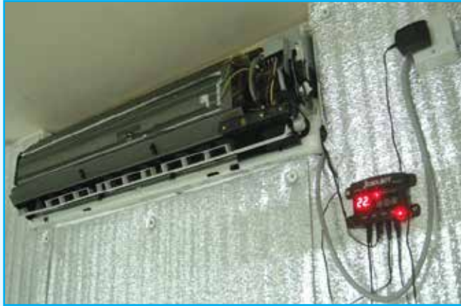
চিত্র-১৮. কুলবোট কুল রুমে নিয়ন্ত্রিত তাপমাত্রায় টমেটো সংরক্ষণ
